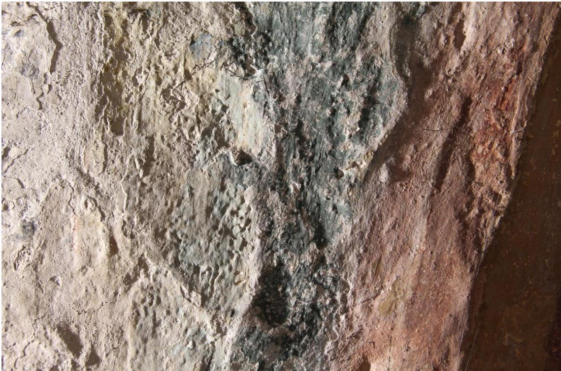
Streiflichtaufnahme von Werkzeug- und Glättungsspuren. Abdruck einer kleineren Löffelkelle.
