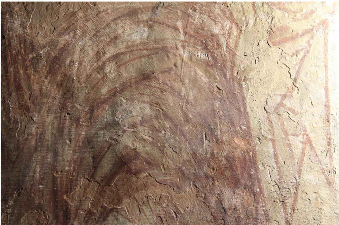
Streiflichtaufnahme der vorbereitenden Kalktünche im Bereich des Gewandes. Die Pinselspuren verlaufen hier in Form eines spiegelverkehrten Z. Rinnspuren der Kalkfarbe zu sehen. Anhand der retuschierten Ausbruchstellen lässt sich auch die Dicke der Tünche ablesen.
