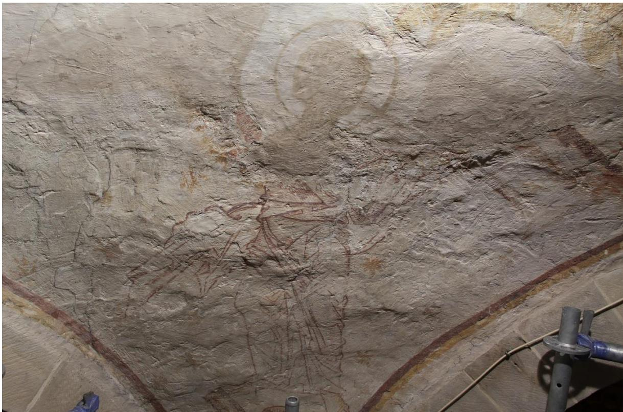
An den kleinen Putzgrenzen wird deutlich, dass dieser Zwickel von unten nach oben verputzt wurde.
