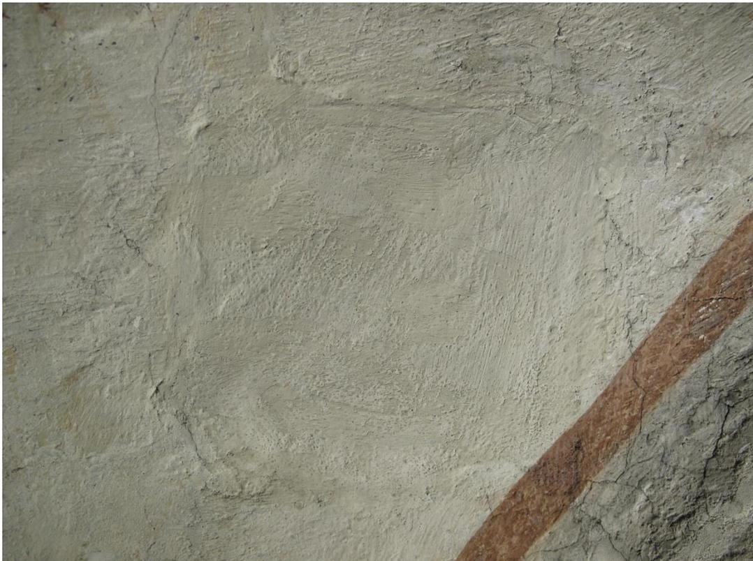
Oberhalb der Köpfe der Auferstehenden zeichnet sich im Putz ein Gerüstloch ab. Die darüber liegende horizontale Putzgrenze bei 7,00 m markiert die ungefähre Höhe der Plattform zum Verputz des Gewölbes. Zum Vergleich: Die Gerüstplattform der Untersuchung 2015 wurde auf Höhe von ca. 6,00 m angesetzt.
