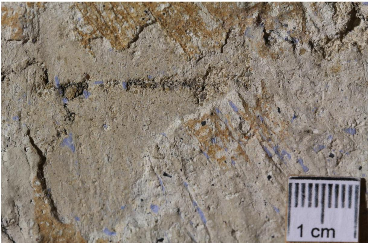
Mittig liegt die Putzoberfläche an einer Ausbruchsstelle frei, umgeben von der 1 bis 2 mm starken Kalkschlämme mit Sand- und Holzkohlezuschlägen.
