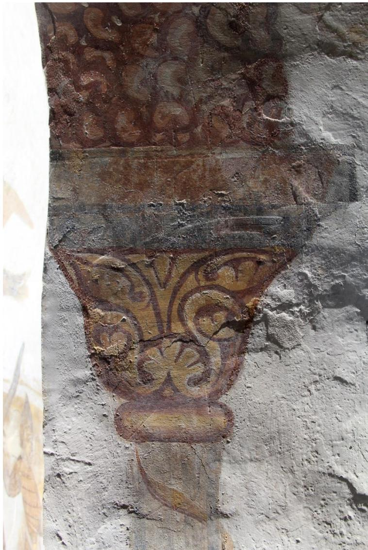
Oberer Teil der Säule im Streiflicht. Markante Glättungsspuren werden sichtbar. Die Malerei ist freskalin in Putz und Kalktünche eingebunden.
