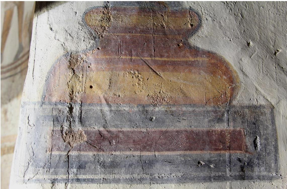
Basis der gemalten Säule im Streiflicht. Glättungsspuren und Läufer der Kalktünche sind sichtbar.
