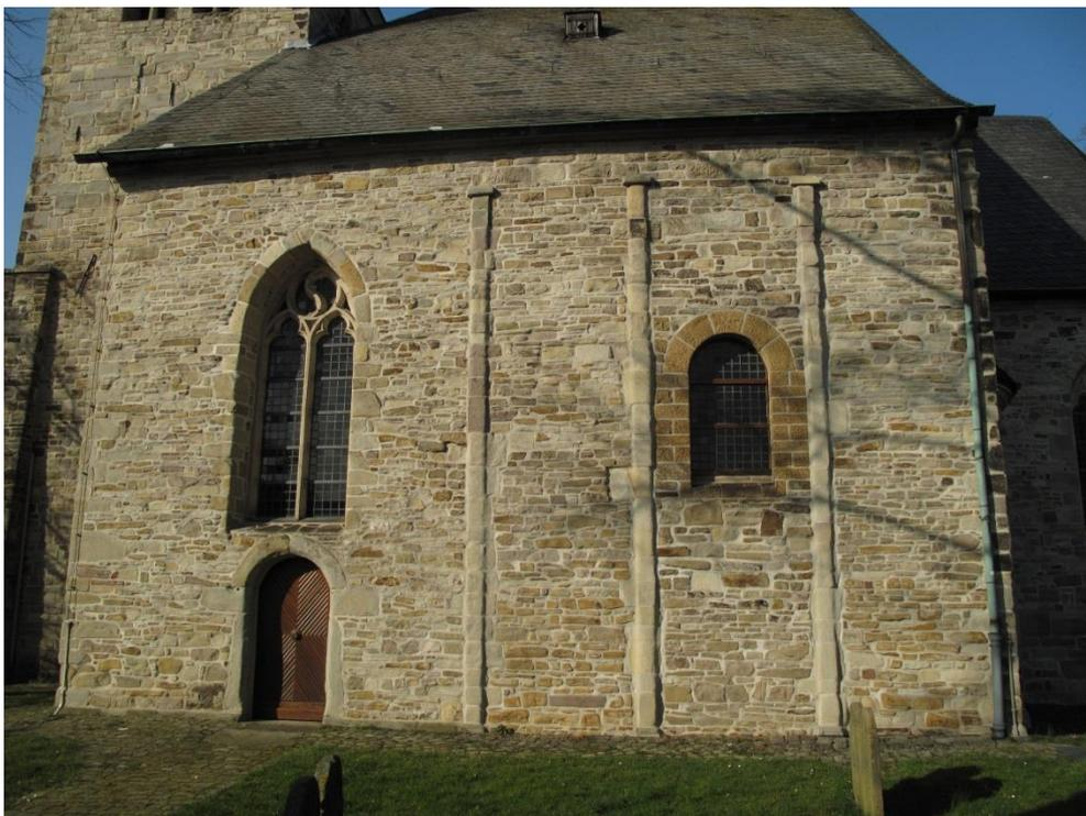
Blick auf die Südseite der Hallenkirche mit der Lisenengliederung ohne Rundbögen und dem reromanisierten Fenster auf der romanischen Querhausstirn und dem Maßwerkfenster über dem schlichten Südportal im gotischen Westjoch des Seitenschiffs. Die äußerste Lisene links bildete ursprünglich die Ecklisene an der Querhausecke, die zum schmaleren Seitenschiff deutlich zurücksprang.
