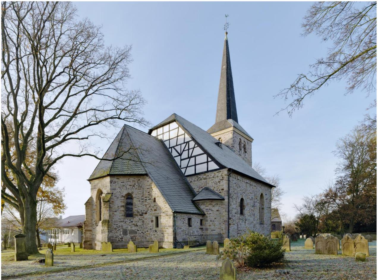
Blick auf den nachträglich angebauten gotischen Chor und die romanischen Bauteile des Nordquerhauses mit der kleinen Seitenapsis, dem Rundbogenfries darüber und den Lisenen auf der Ostwand und der Nordwand des Querhauses. Gen Westen wird die Außenmauer der gotischen Erweiterung des Seitenschiffs sichtbar, mit größerem Spitzbogenfenster und fehlendem Rundbogenfries. Dahinter erscheint der zum romanischen Baukörper gehörige Westturm.
